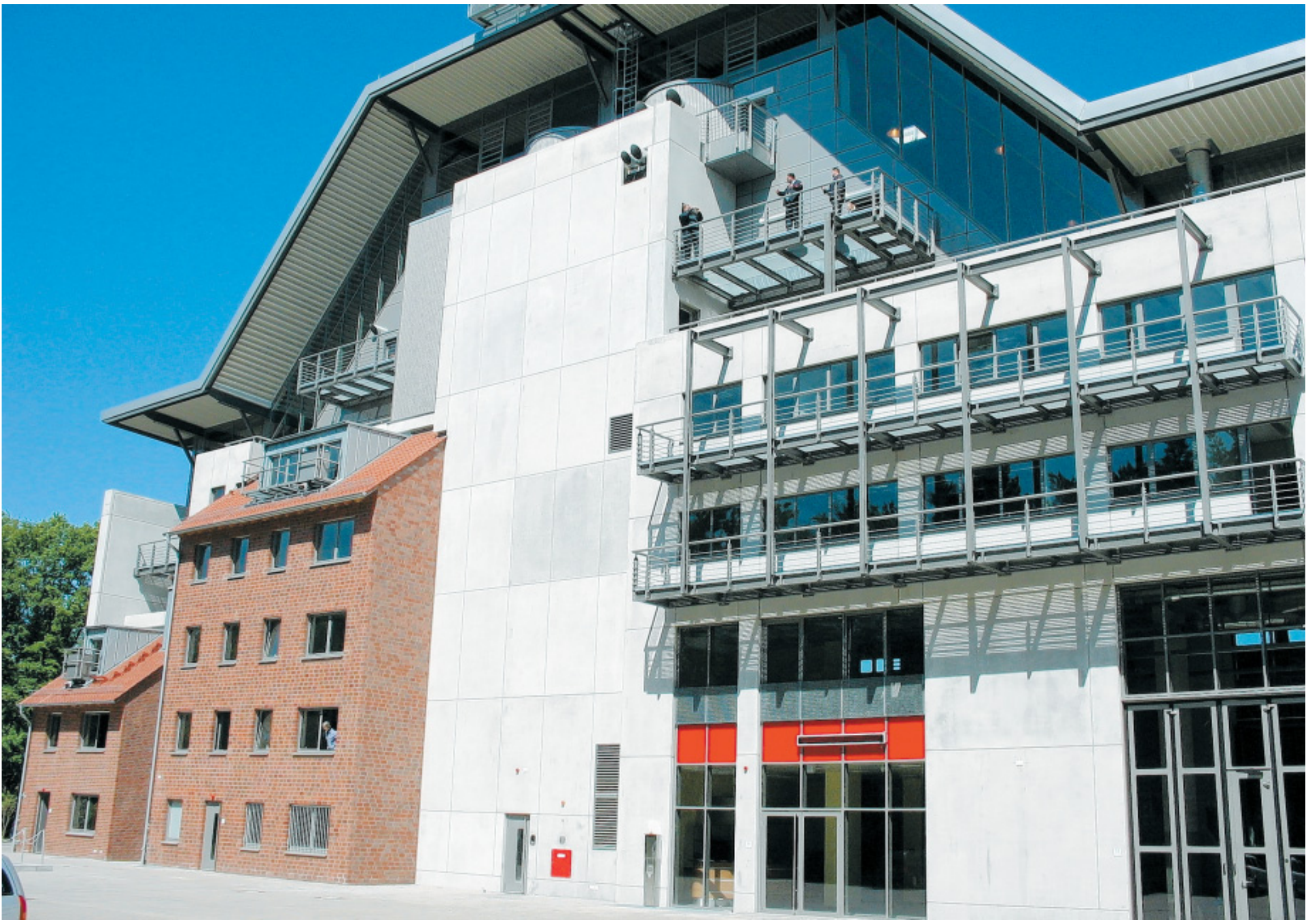
Prestigebau: Dieses Schul- und Übungszentrum der Feuerwehr steht in Telgte bei Münster. Die Decke ist bis zu 25 Meter hoch, damit im Inneren komplette Wohnungsbrände simuliert werden können.
