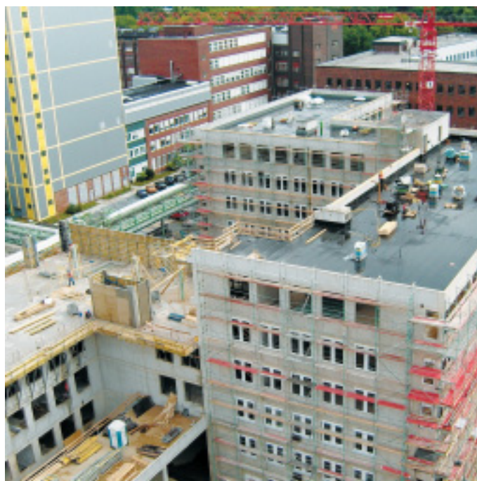
Verwaltungs- und Bürohaus: Im Herzen der Bayer AG in Leverkusen wird zurzeit nach Grotemeiers Plänen gebaut.
